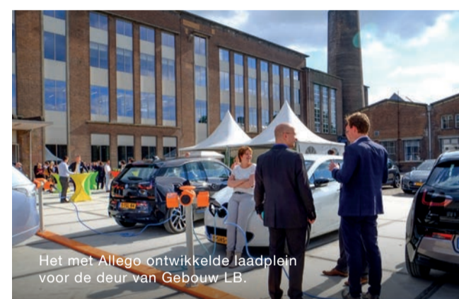
Het met Allego ontwikkelde laadplein voor de deur van Gebouw LB.
